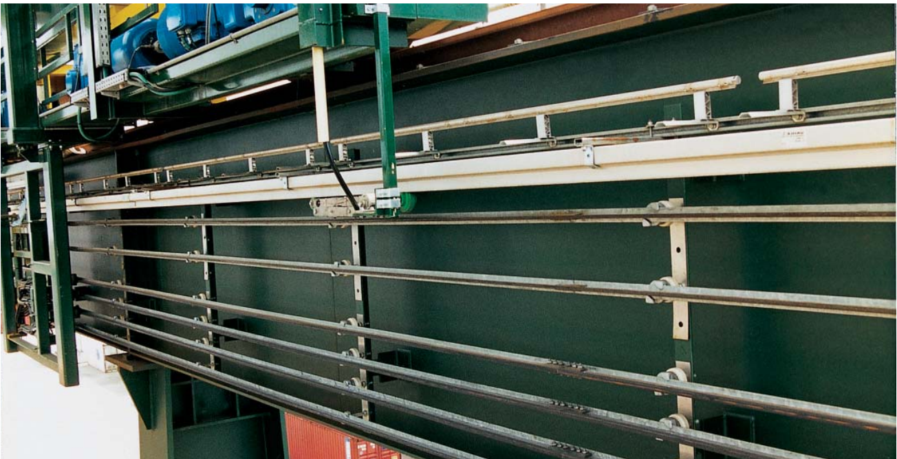
Antennenführung SMG-RAE-XY-6 im Einsatz bei einem Großkran.
